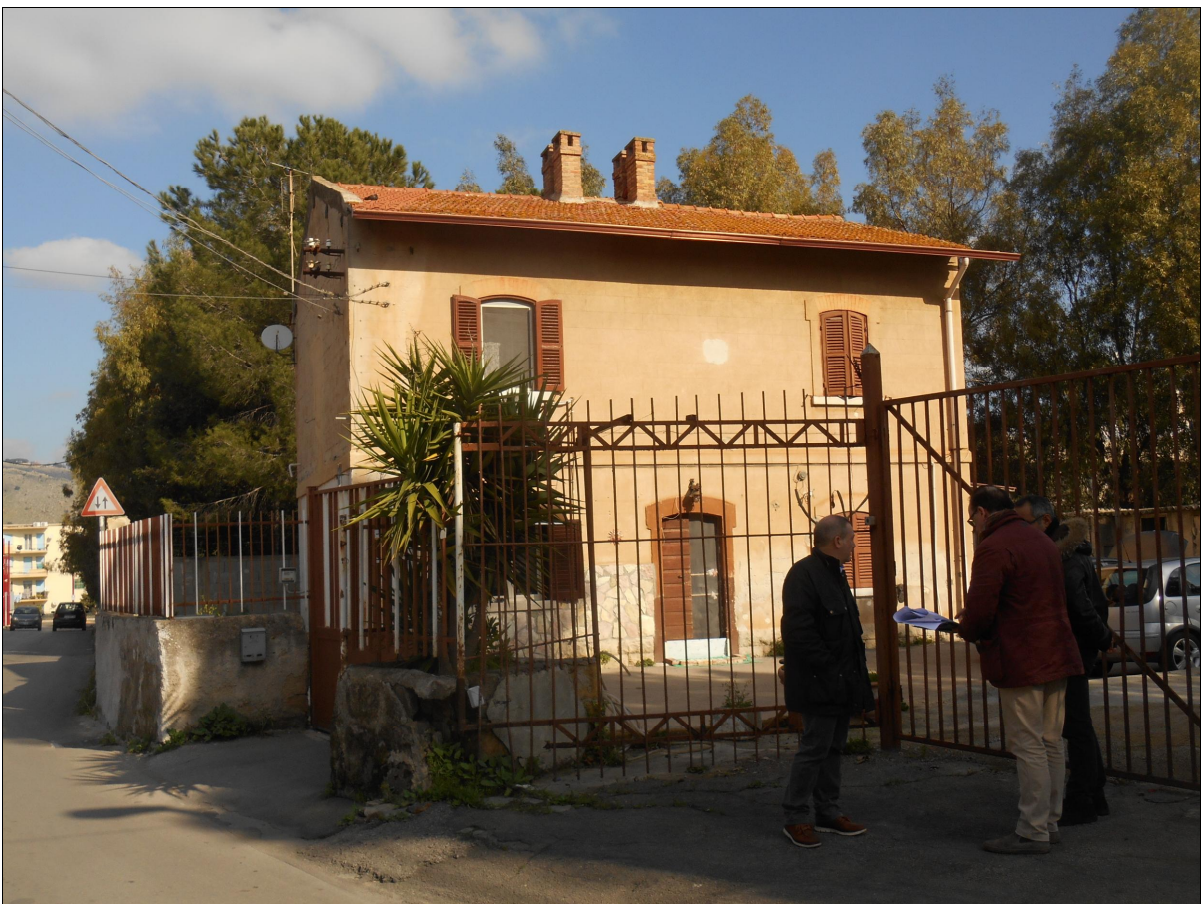
2 a Casa Cantoniera – Via S. Isidoro
